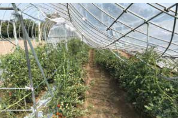
▲2019年の台風で被害を受けたミニトマトのハウス
